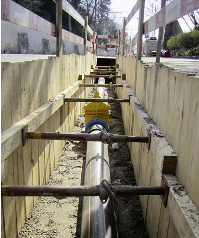
Abbildung 1: Beispiel Grabenspriessung für Werkleitungsbau
