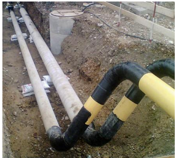
Abbildung 2: Beispiel Rohrbettung für Erdgashochdruckleitung
