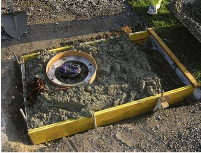
Abbildung 6: Erstellung Fundament für Trinkbrunnen Typ Basel
