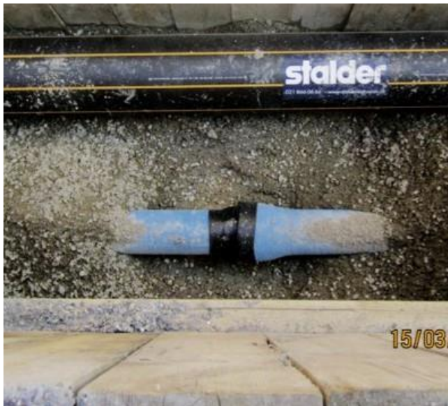
Abbildung 3: Eindeckung der Rohre mit freigelassener Verbindungsmuffe
